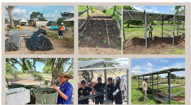
Fotografías del proyecto de electrificación rural circular en San Ángel, Cesar, Colombia. Beneficiarios y equipo del proyecto implementando soluciones agrovoltáicas construidas con restos de construcción de parques solares comerciales de ENEL.
